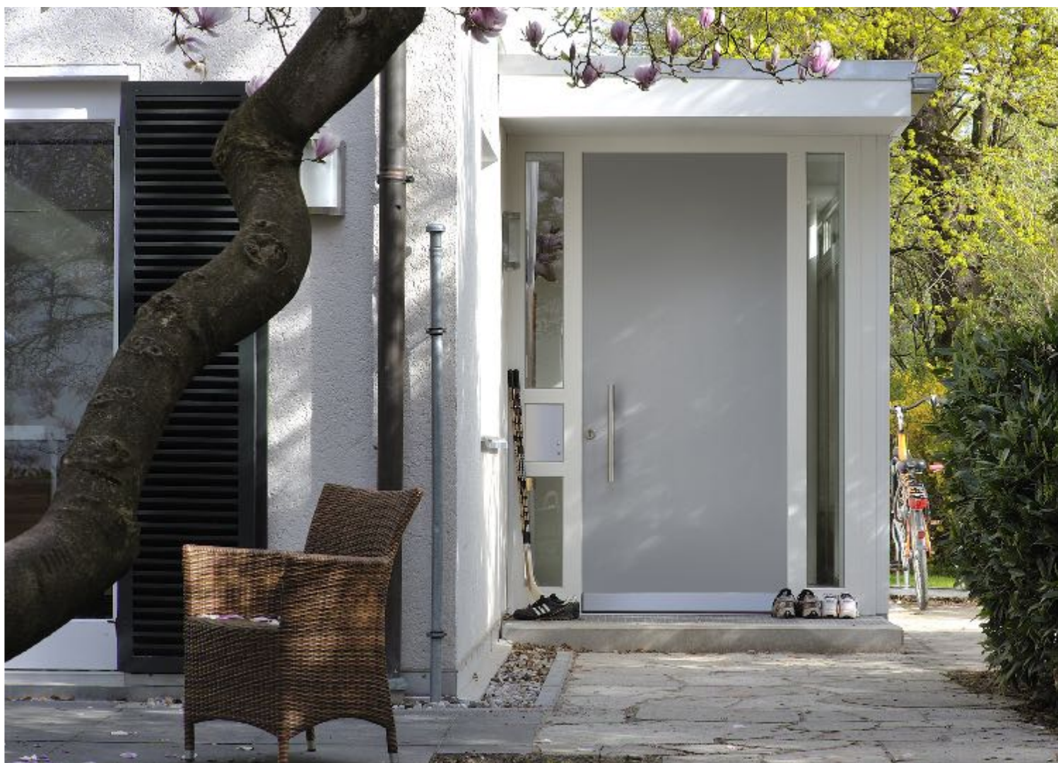
Neuer Eingangsbereich nach Umbau
