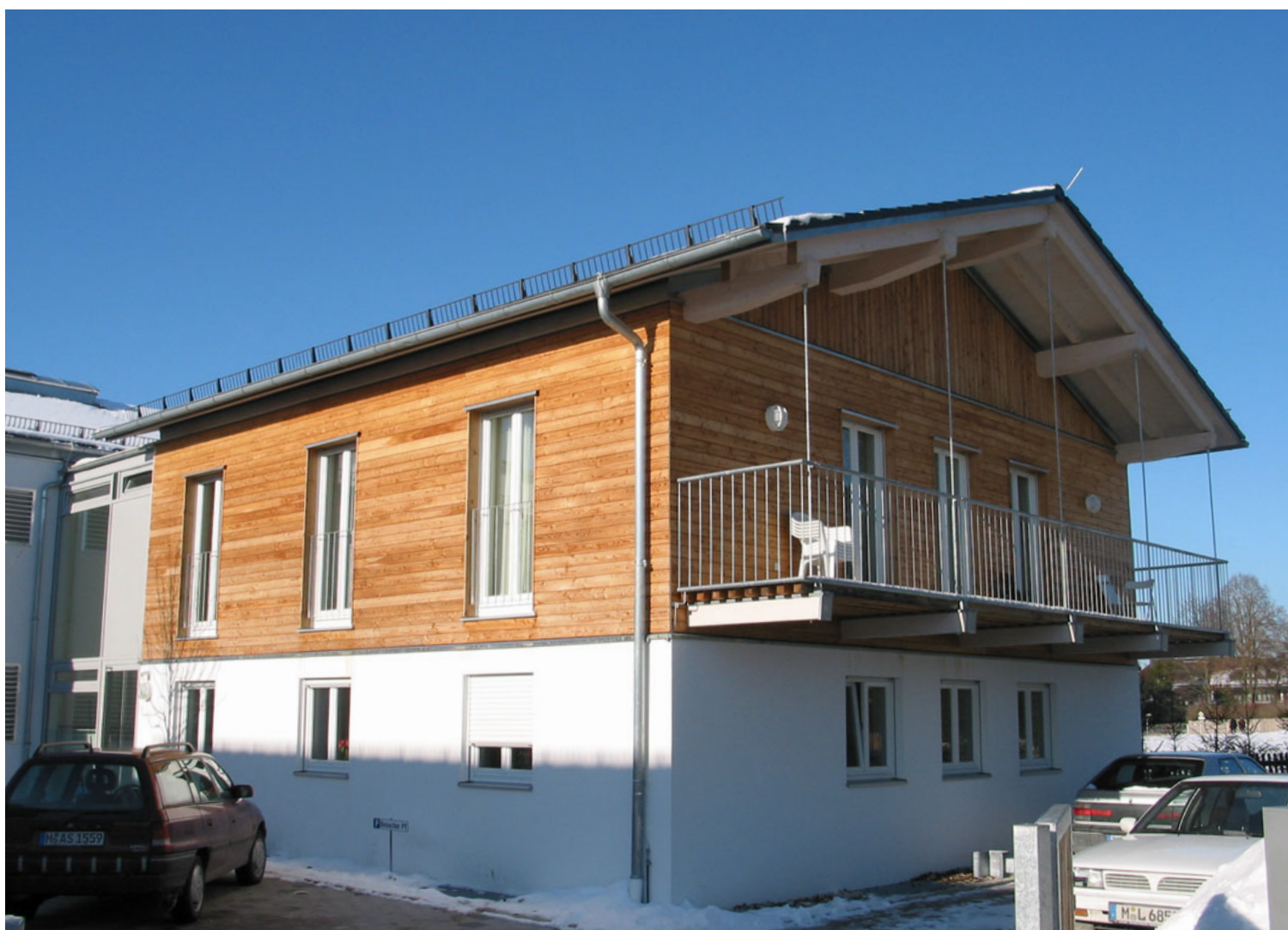
Foto Erweiterung Nordflügel
