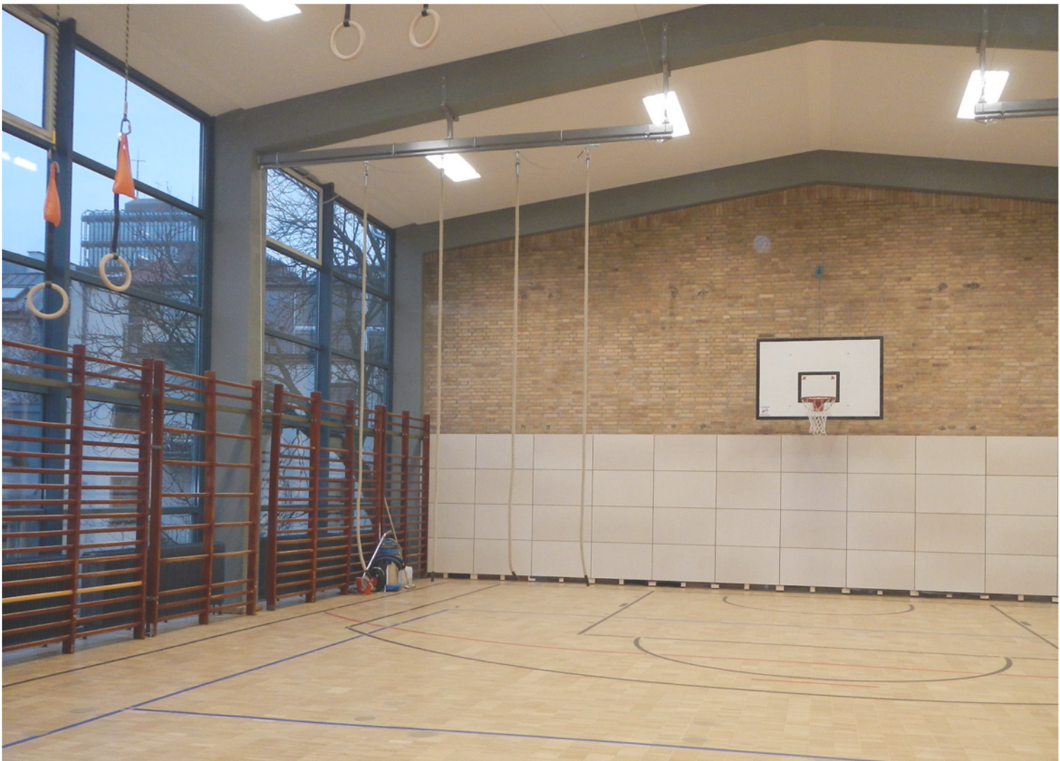
Sporthalle 1.OG nach der Sanierung
