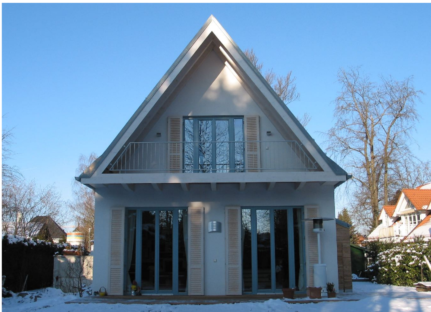
Südfassade nach Umbau
